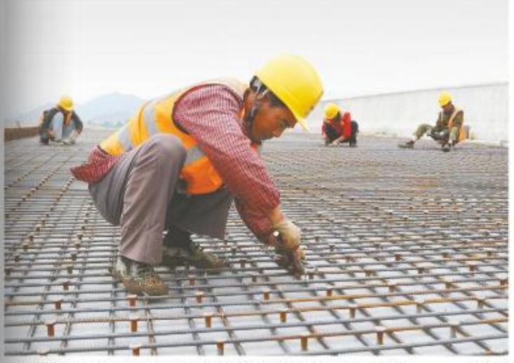
汉中市住房和城乡建设局工作人员在施工现场检查工程质量。
